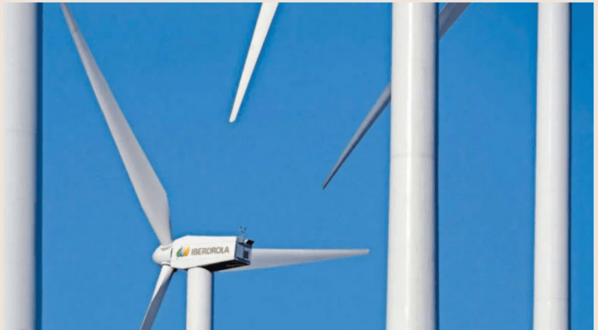
Aerogeneradores de Iberdrola en su parque eólico de Higuera, en Albacete. GETTY IMAGES
